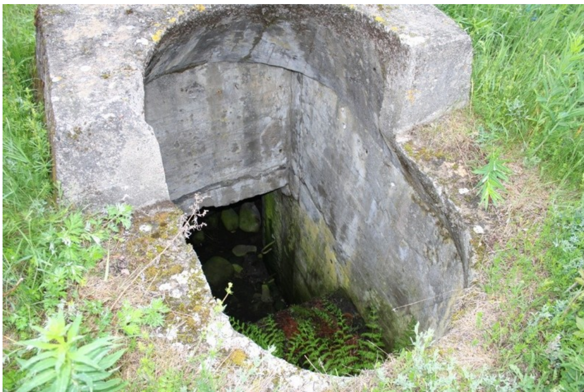
Основание для наблюдательного бронеколпака.
