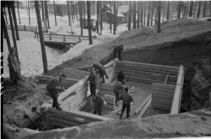
Видлица. Строительство телефонного узла. Март 1944 г. Строят Советские военнопленные (без верхней одежды), Охранник в шинели сторожит.
