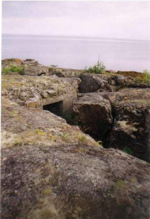
4. Башня управления огнём. Три этажа, бетон. Нижняя часть была обложена булыжником (остались скобы от его крепления). Внутри, до 2004 года была красивая винтовая чугунная лестница. Затем её спёрли. Наверху башни помещение управления огнём, смотровая щель и круглый бетонный стол, а на крыше круглая площадка для дальномера (остались следы от металлического кольца по периметру).
